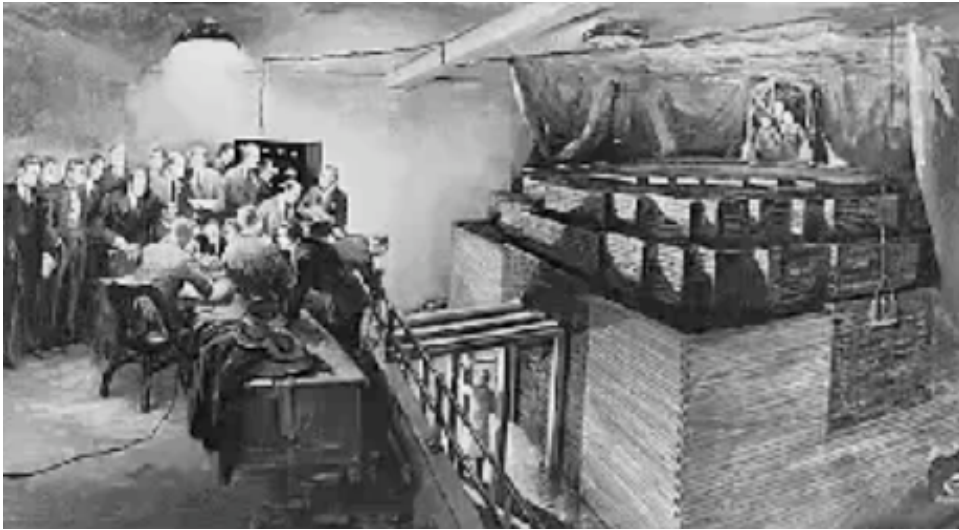
Controllo del reattore con barre di cadmio
