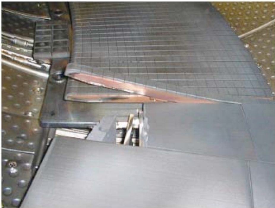
Figure 2.18 – Exemple de déformation engendrée par des courants induits : aiguille tordue d'un limi-teur de Tore Supra, plaque de CFC cassée
